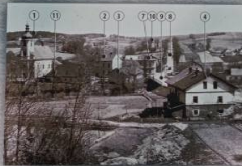
Střed obce s dřevěným povalečným mostem, r. 1955
